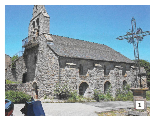
1 – Das Roadbook hat regelmässig historische Gebäude und Denkmäler im Repertoire.
